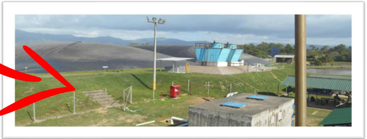
Planta de tratamiento de aguas residuales (ERH), cuenta con lagunas carpadas que capturan los gases generados por estos residuos líquidos y son utilizados para generar energía para la planta.
